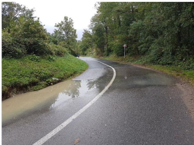
Photo source adhérent
